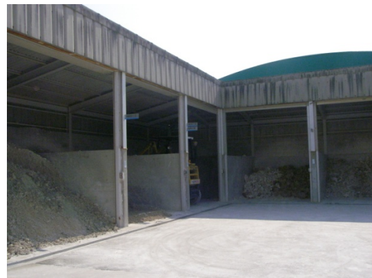
製造工程廃棄物 リサイクル置き場
